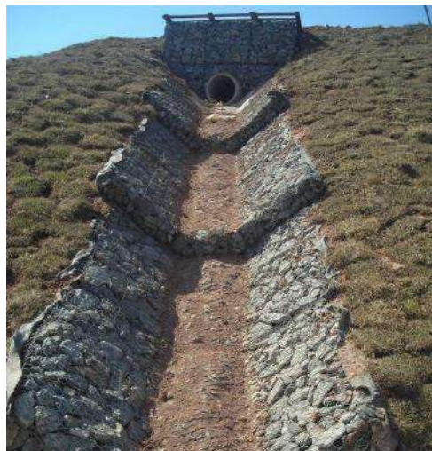
Figura 8 - Exemplo de descida hidráulica de gabião tipo manta (colchão).
