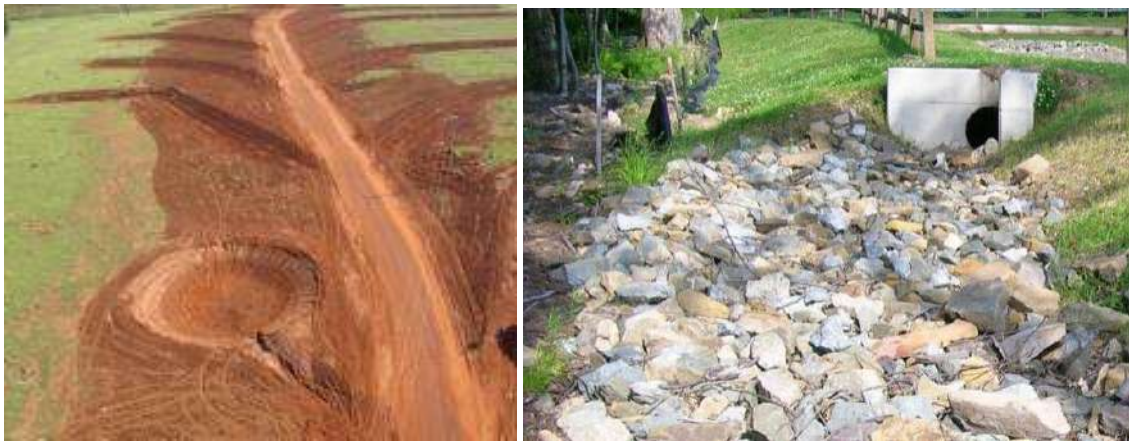
Figura 11 - Exemplo de bacia de retenção (a) e de bacia de enrocamento (b).
