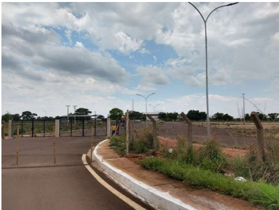
Figura 165 - Estação Intermodal de Cargas – Porto Seco Fonte: Elaboração própria
