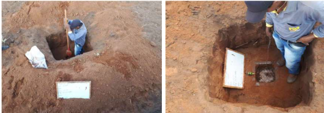
Figura 58 - Execução dos furos de sondagens e ensaios de infiltração de água no solo
