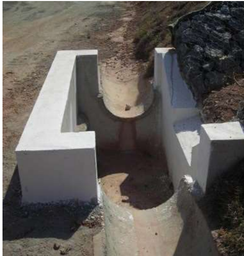
Figura 9 - Exemplo de caixa de passagem Tipo 1 na interligação de descidas hidráulicas com canaletas/canais e travessia subterrânea.
