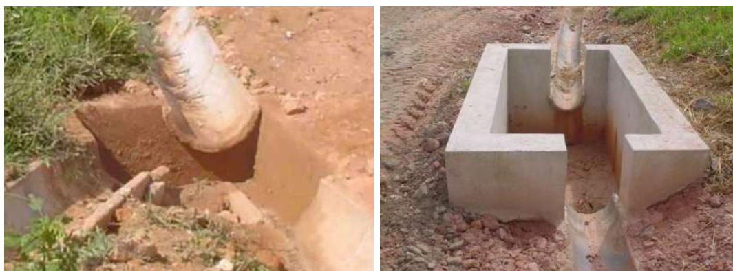
(a) (b) Figura 10 - Exemplo de caixa de passagem Tipo 2 entre canaletas/valetas, de mudança de direção (a) e de diminuição de energia nas canaletas (b).
