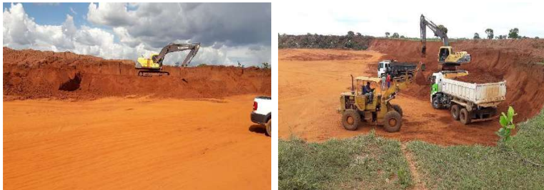
Área de empréstimo da Prefeitura – Terminal Intermodal de Campo Grande Rodovia BR 262 – 351 Km - 20°34'46.,9" S - 54°37'35,0" W (AID)
