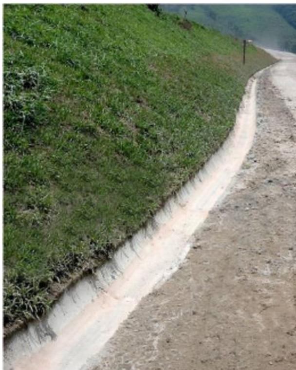
**Figura 5-2. Exemplo de canaletas de concreto tipo meia-cana.**
