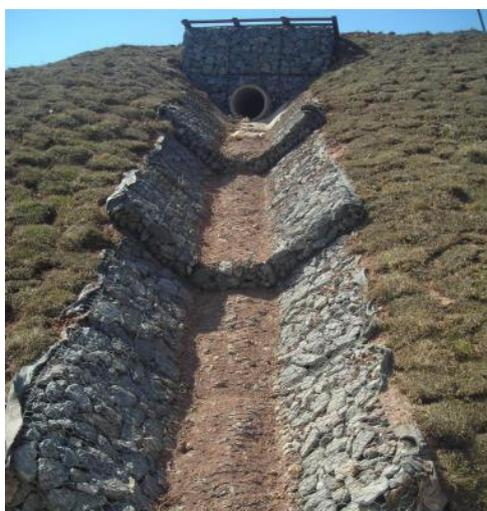
**Figura 5-3. Exemplo de descida hidráulica de gabião tipo manta (colchão).**
