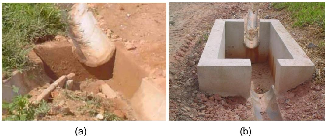
**Figura 5-5. Exemplo de caixa de passagem Tipo 2 entre canaletas/valetas, de mudança de direção (a) e de diminuição de energia nas canaletas (b).**
