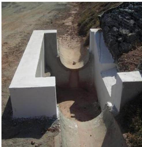
**Figura 5-4. Exemplo de caixa de passagem Tipo 1 na interligação de descidas hidráulicas com canaletas/canais e travessia subterrânea.**
