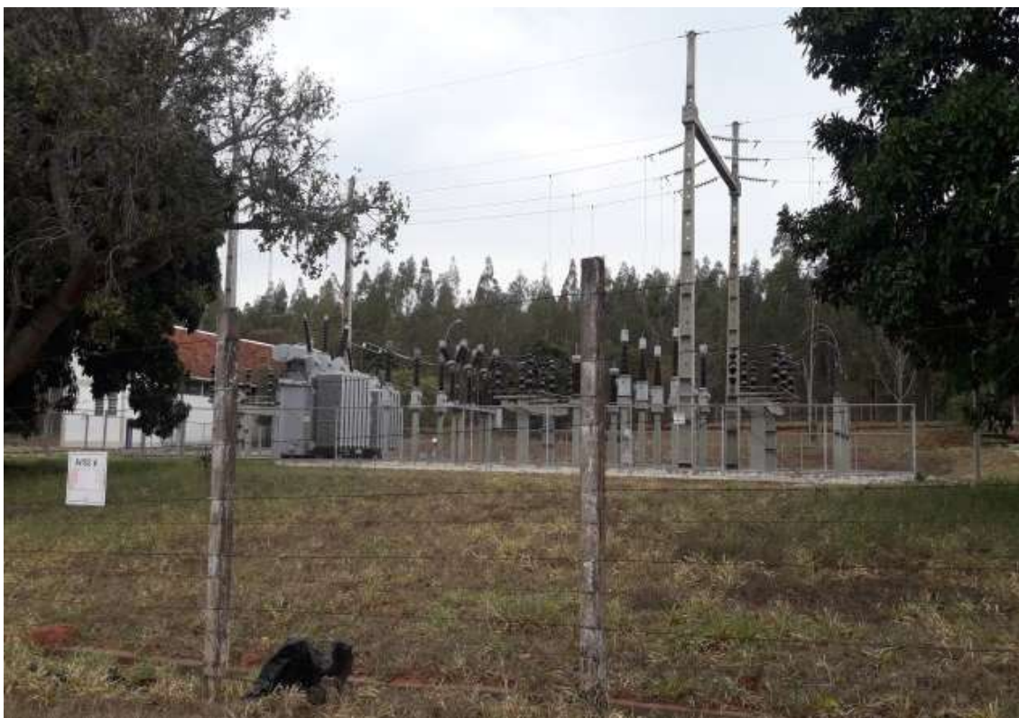
Figura 215 - Subestação de energia elétrica
