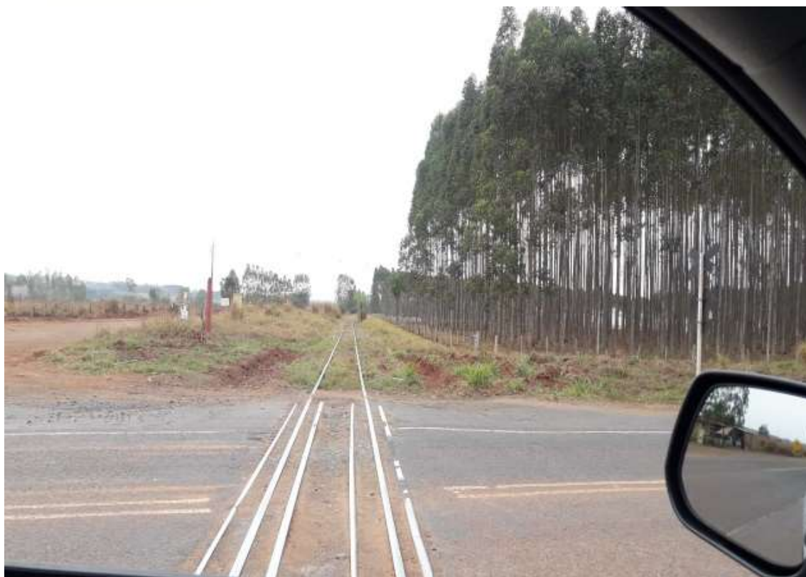
Figura 218 - Ferrovia de escoamento e recepção de produtos para a cidade de Campo Grande
