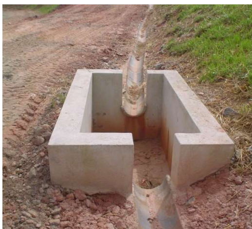
Figura 49 - Exemplo de caixa de passagem Tipo 2 entre canaletas, de mudança de direção (a) e de diminuição de energia nas canaletas (b).
