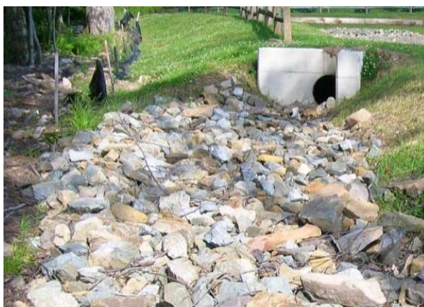
Figura 50 - Exemplo de bacia de retenção (a) e de bacia de enrocamento (b).
