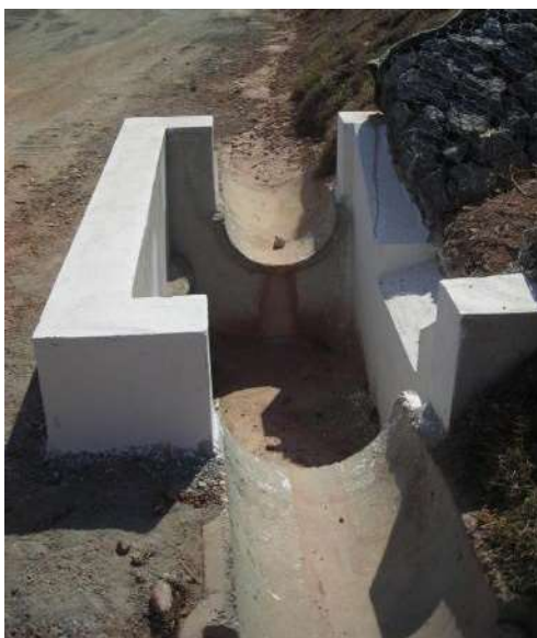
Figura 48 - Exemplo de caixa de passagem Tipo 1 a jusante das descidas hidráulicas, entre canais trapezoidais e tubos de concreto.
