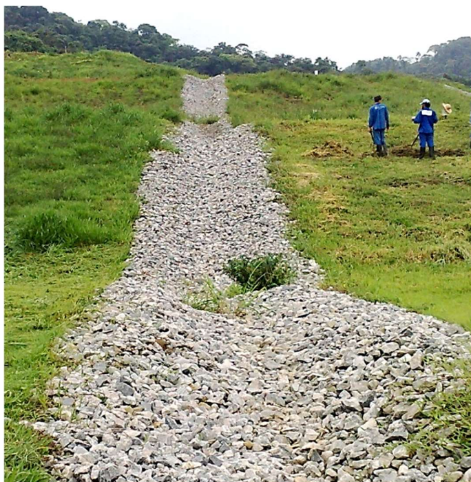
Figura 47 - Exemplo de descida hidráulica em geocélula preenchida por pedras.
