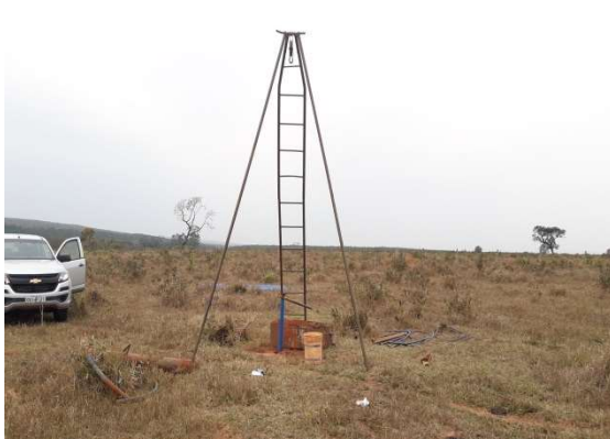
Construção dos poços de monitoramentos
