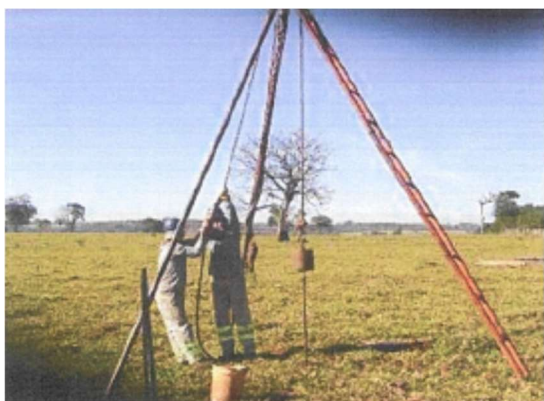
Construção dos poços de monitoramentos
