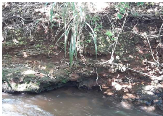
B)Afloramento de Basalto em processo de alteração Local: Sítio do Seo Olário margem direita do Córrego Ceroula - 20°23'18,0" S - 54°40'08,5"W
