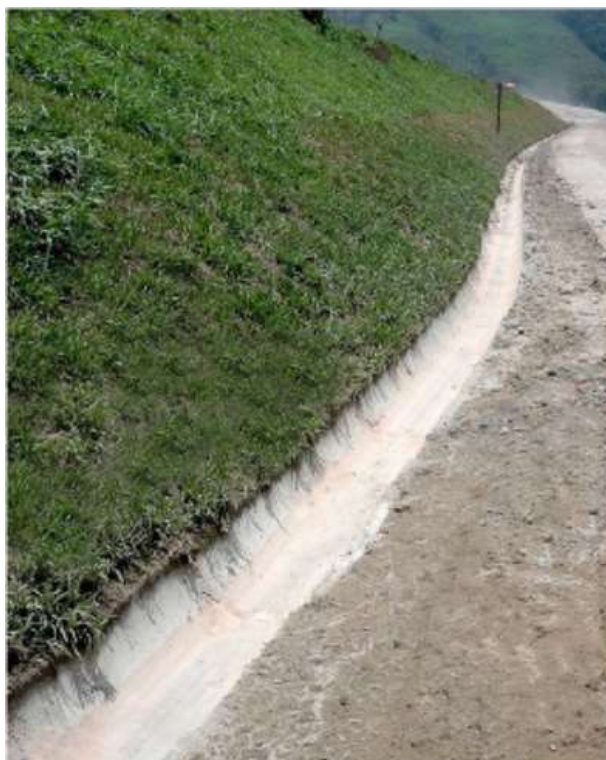
Figura 46 - Exemplo de canaletas de concreto tipo meia-cana
