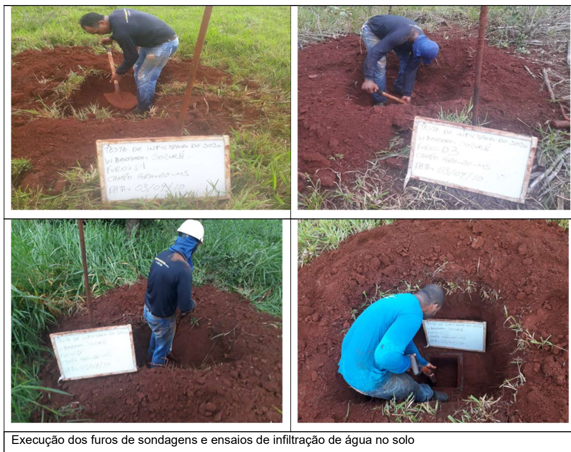
Figura 16 - Execução dos furos de sondagens e ensaios de infiltração de água no solo
